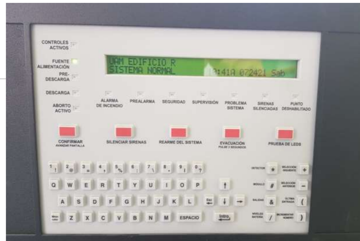
MANTENIMIENTO PREVENTIVO A SISTEMA DE DETECCIÓN DE INCENDIO EDIFICIO "R" Y "A-S"
